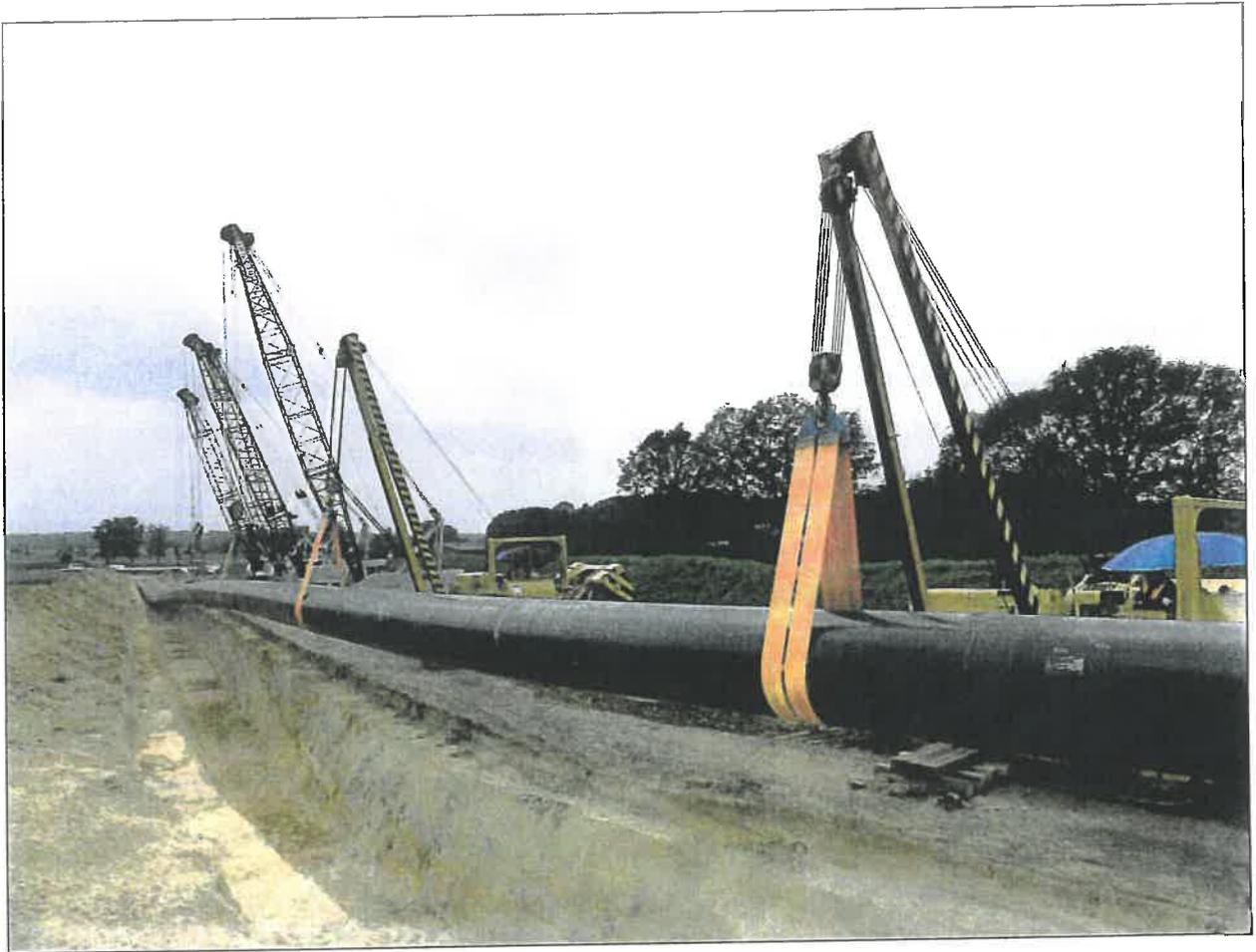
**Abbildung 8: Absenken des Rohrstranges**
