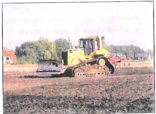
Abbildung 10: Rekultivierung des Arbeitsstreifens
