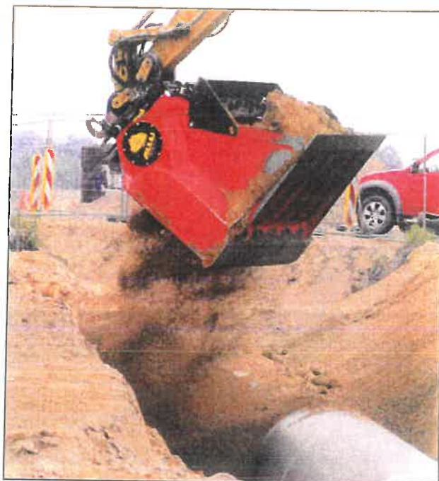
Abbildung 9: Verfüllen des Rohrgrabens
