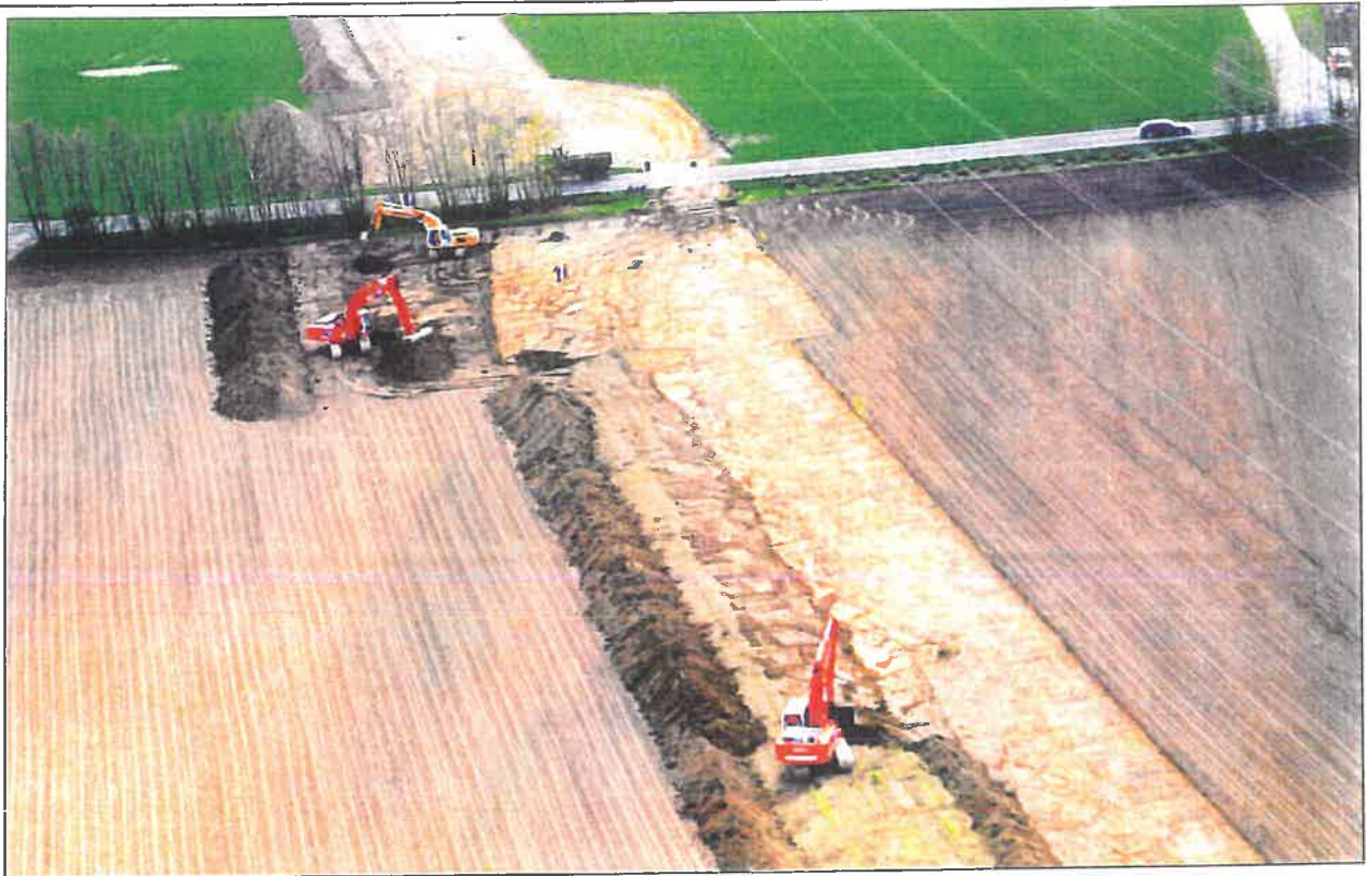
Abbildung 6: Abschieben und Lagern des Oberbodens
