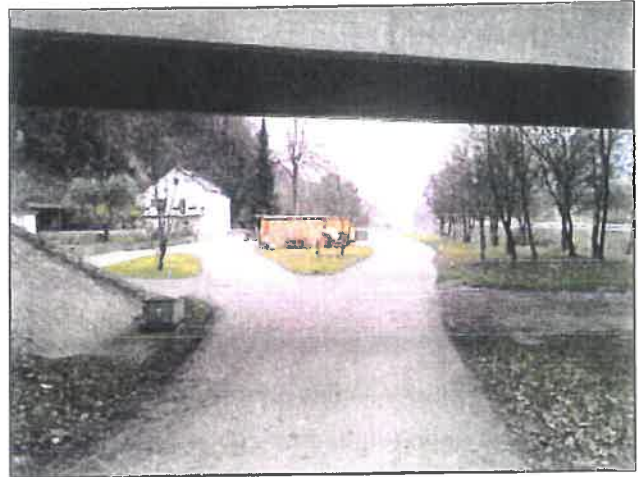
Abbildung 13: Brücke KEH5, Ortslage Heidenstein
