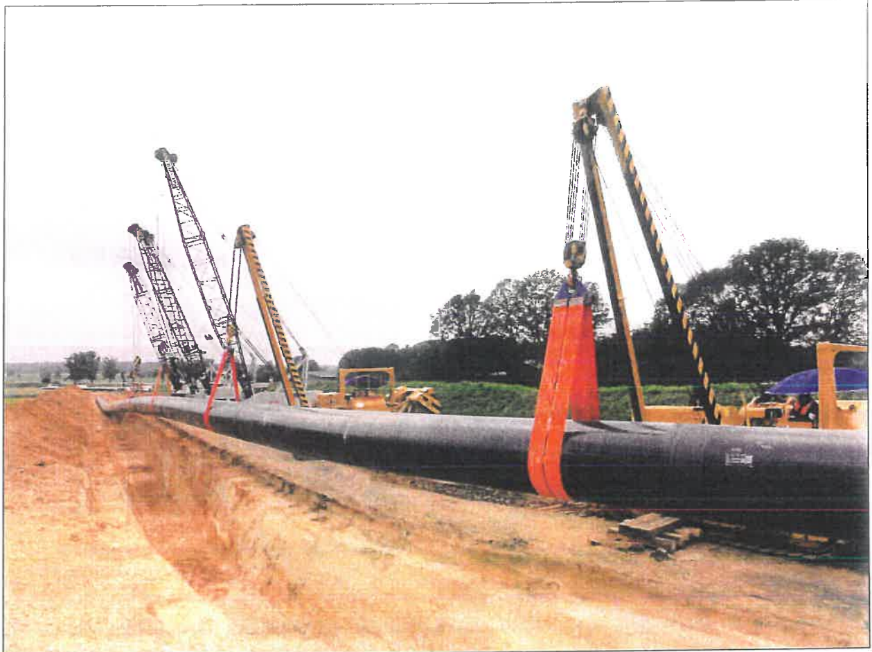
Abbildung 8: Absenken des Rohrstranges
